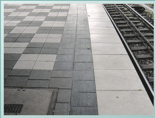
Einstiegsbereich einer U-Bahnhaltestelle
