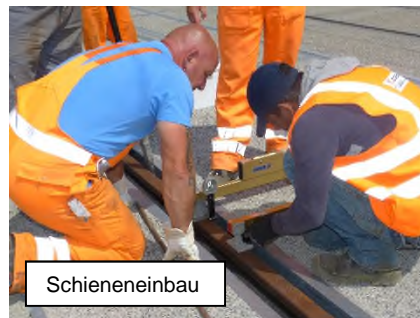
Abladen, Überhöhung anpassen
