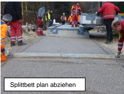
Frostsicheren Untergrund herstellen
