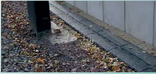
Parallelverlegter MPO Kunststoffkabelkanal
