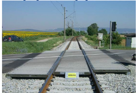
Foto 15 Fertig eingebauter Übergang, Österreich
