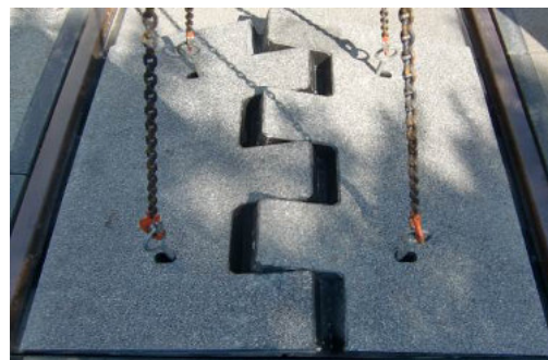
Foto 4 Die beiden Platten werden in Montageposition gebracht
