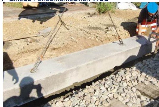
Foto 7 Einbau Fundamentbalken WUB
