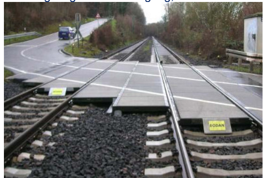
Foto 17 Fertig eingebauter Übergang, Deutschland
